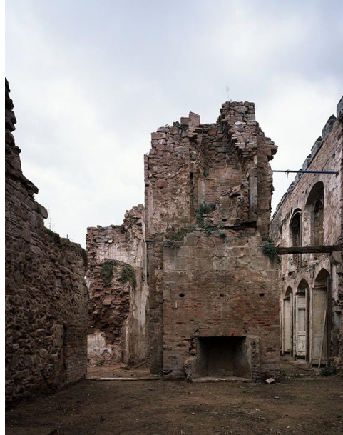
Resim: 17 Yangın sonrası harap olmuş kısım ve yine aynı noktada yeni yapıda bu defa döşeme tamamlanmadan, iki kat yüksekliğinde bırakılarak tasarlanan yemek mekanı (Foto: Landmark Trust, URL 9).
