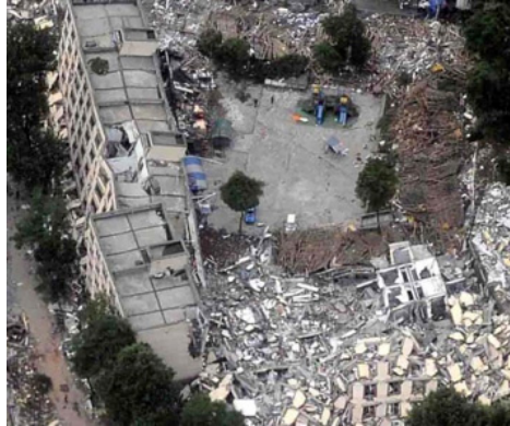
Şekil: 2 Deprem sonrası konut hasarları (URL (i))
