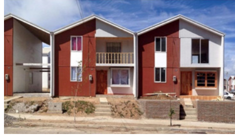
Şekil: 10 Sosyal konutların yarı inşa edilmiş halleri ve konutların diğer tamamlanan kısımları (URL (7)).
