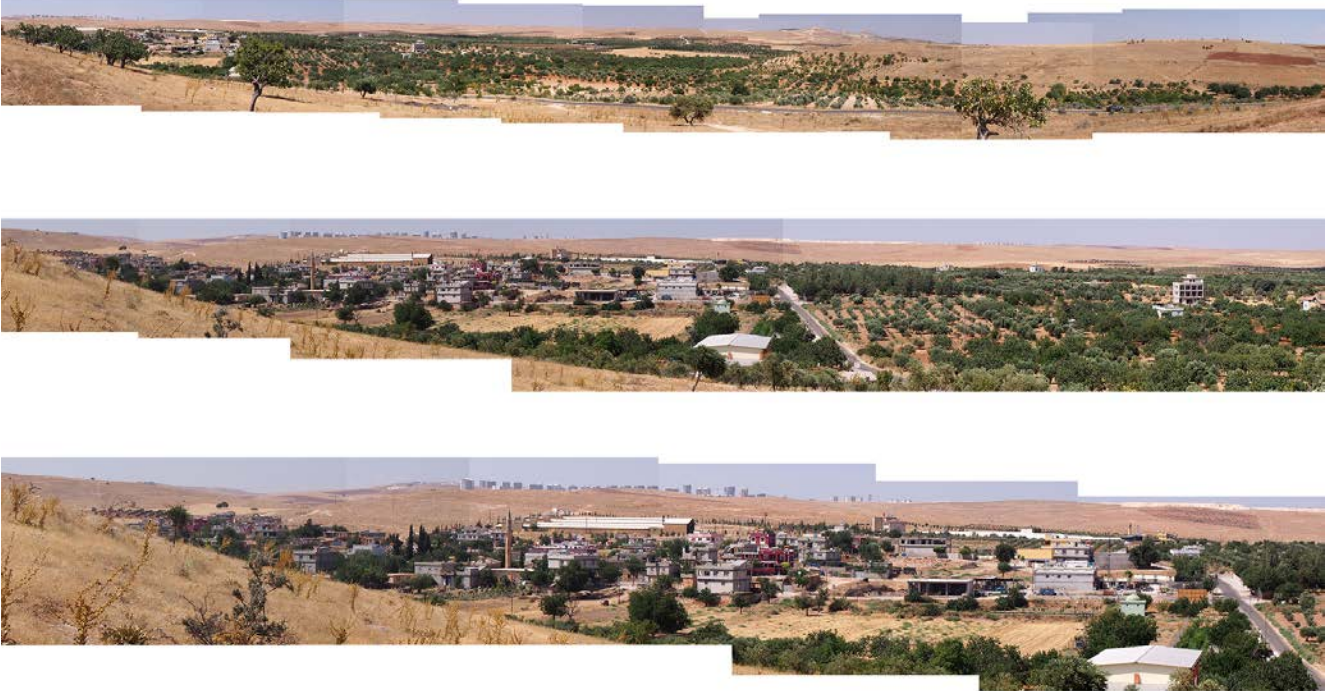
Şekil: 7 Geneyik Mahallesi Genel Görünüm.
