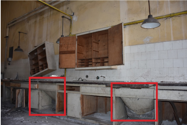
Şekil 13. Tezgâh altı havalandırma sistemi (Yarlıgaş 2019).
