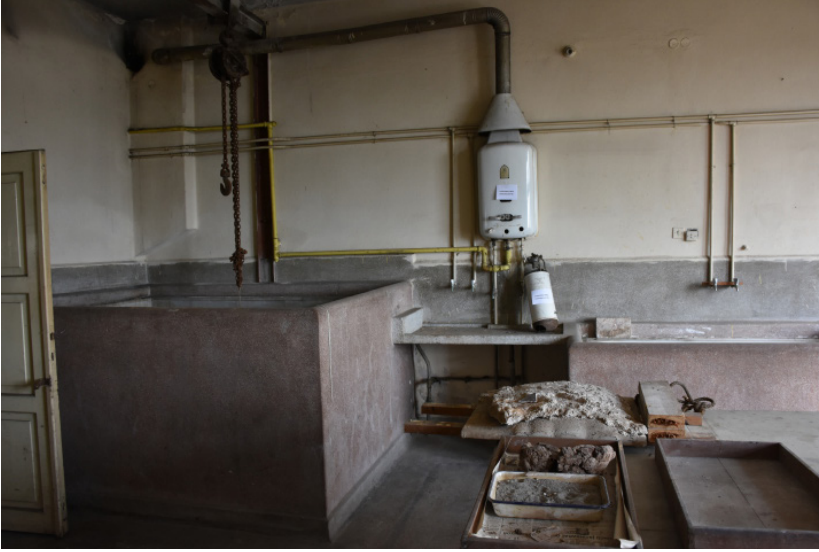
Şekil 19. Büyük beton daldırma havuzlarının olduğu oda (Yarlıgaş 2019).
