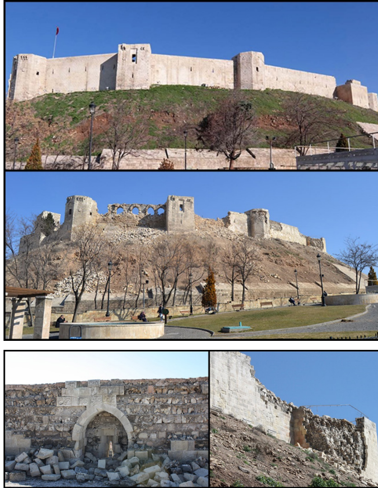
Şekil 16. Üstte; deprem öncesi kalenin genel görünümü (Gaziantep Büyükşehir Belediyesi KUDEB arşivi, 2019), altta; deprem sonrası kalenin genel görünümü (Cansunar arşivi, 2023). Şekil 17. Deprem sonrası kalede oluşan tahribatlar (Cansunar arşivi, 2023).
