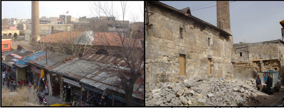
Şekil 6. Solda; Beden duvarına bitişik dükkanlar, sağda; muhdes dükkanlar kaldırıldıktan sonra anarım öncesi güney cephesi (Gaziantep Vakıflar Bölge Müdürlüğü arşivi, 2008)
