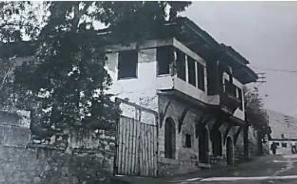
Şekil: 14 Muğla Zahireci Pazarı Sokak 13/ A nolu Akarca'lara ait ev ön cephe, Tayla'nın görev aldığı Muğla Tespit-Tescil çalışmaları (IRAM Arşivi; Billur 2020, 165).
