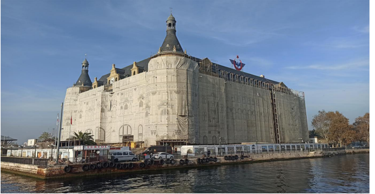
Şekil: 2 Haydarpaşa Tren Garı restorasyon çalışmaları, 2021.
