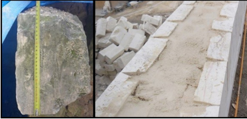
Şekil 1. Solda geleneksel yapım tekniğinde kullanılan taş örneği (Cansunar, 2019, 44), sağda günümüzde kullanılan düz satırlı taş örneği (Gaziantep Büyükşehir Belediyesi KUDEB arşivi, 2013).
