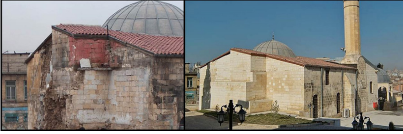
Şekil 3. Solda; Şirvani Cami güney cephesi onarım öncesi durumu (Gaziantep Vakıflar Bölge Müdürlüğü arşivi, 2003), sağda; onarım sonrası durumu (Gaziantep Vakıflar Bölge Müdürlüğü arşivi, 2008)
